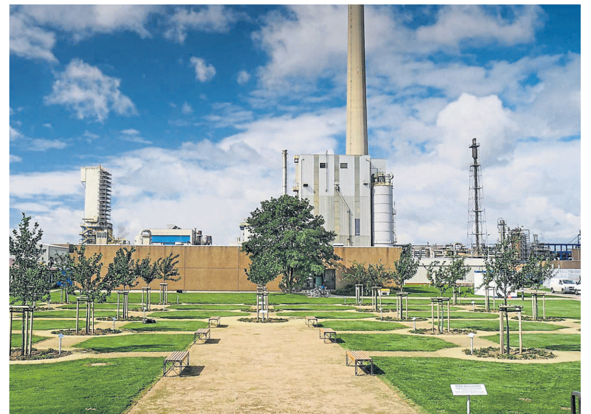
Ungewöhnlich für eine Industrieanlage: der Apfelgarten im Yara-Werk Brunsbüttel.
