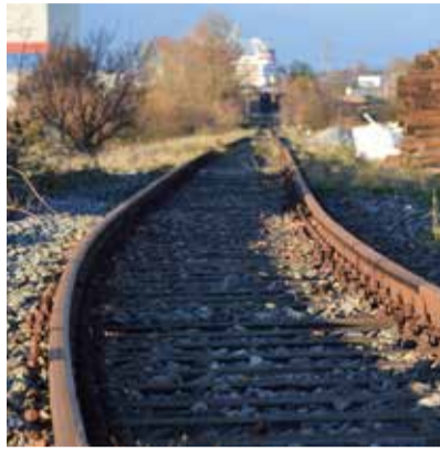
Industriegleis in Brunsbüttel © egeb
