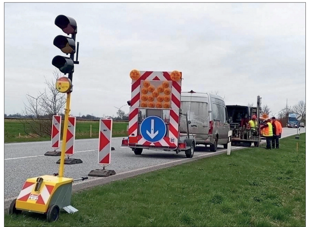
Mit den Baugrunderkundungen zum dreistreifigen Ausbau der B5 zwischen Brunsbüttel und Wilster wurde bereits begonnen. © LBV.SH
