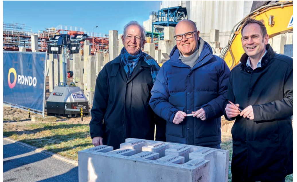
Symbolischer Spatenstich in Brunsbüttel: (v.l.) John O'Donnell, CIO und Gründer von Rondo Energy, Energiewende-Minister Tobias Goldschmidt und Dr. Thorsten Dreier, CTO von Covestro, unterschreiben einen Ziegelstein, der in der Wärme-Batterie verbaut wird. © Covestro
