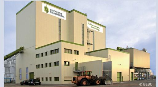
Die Bioenergie Contracting Brunsbüttel GmbH (BEBG) betreibt am Standort Brunsbüttel seit September 2008 ein modernes Biomasse-Heizkraftwerk mit einer Feuerungs-wärmeleistung von 30 Megawatt (MW) und versorgt damit drei benachbarte Industriebetriebe im ChemCoast Park Brunsbüttel mit Prozess- und Heizdampf. Der «grüne Strom» wird ins öffentliche Netz eingespeist.
