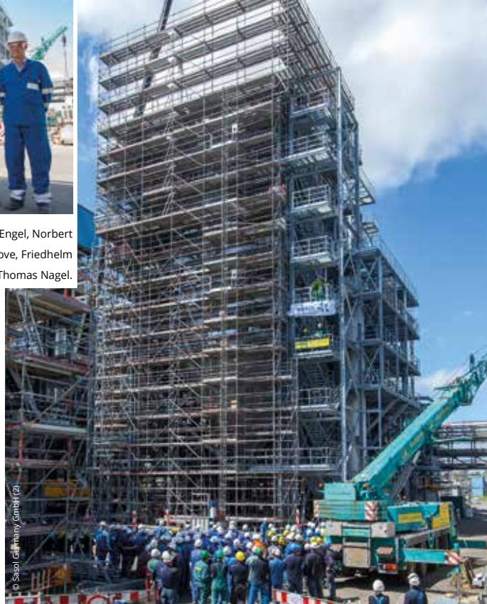
Festakt in Brunsbüttel: Die Baustelle des neuen Sprühtrockners mit Richtkranz.
